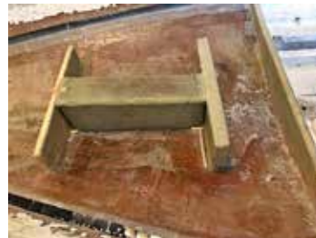
Förstärkning under mastfoten.
