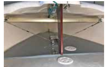
Skrovets förstävning med vajrar och balk som ersättning för mittskott.
