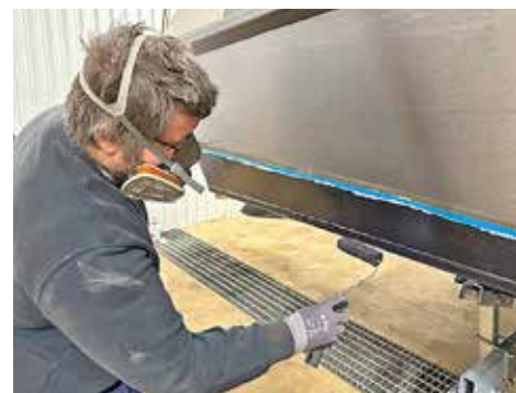
Slutmålning med topplagret.
