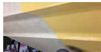
När den gula tiecoatskiktet är målat börjar klockan ticka. Det är viktigt att följa anvisningarna för tid och lufttemperatur.
